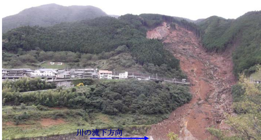
写真 1 崩壊地を望む（川上村迫）
